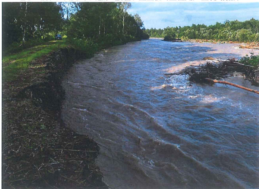
増水で崩れた音更川の堤防（23日、上士幌町上音更。塩原真撮影）
