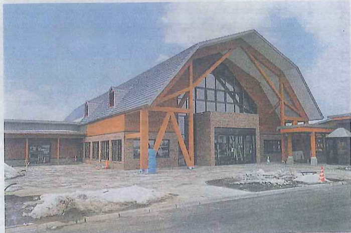
建設が進められている新・道の駅ピア21しほろの外観
